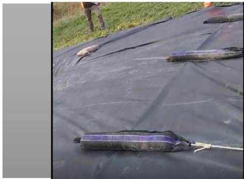
Figuur 5: Zandzakken voor stabilisering: vastgemaakt aan krammen bovenaan.
