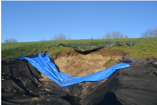
Figuur 2: uitgangssituatie (foto van 23 november). Zandkern ligt bloot, overloop leidt rap tot groei van schade.
