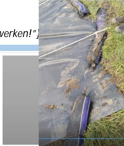
Figuur 3: Situatie bovenaan: dubbelgeslagen folie schuin ingestoken onder graszode (die was tijdelijk opgelicht, NIET geheel weggehaald voor terugleggen).
