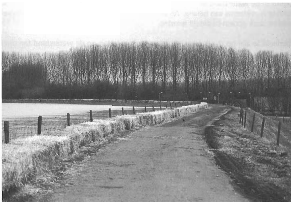
Bij een smalle dijk worden stobalen gebruikt om de kruin op te hogen.
