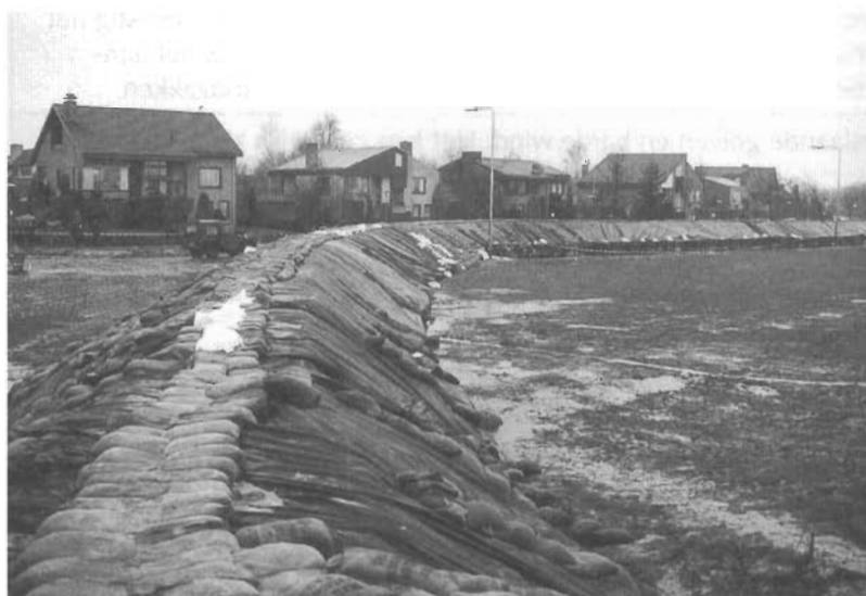
Bij overslag kan een kade op de dijk worden aangebracht die maximaal 0,75 meter hoog mag zijn.
