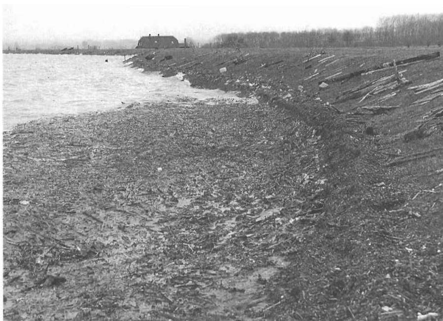
Drijfvuil verzamelt zich bij de dijk. Omdat het de dijk kan beschadigen moet het zo snel mogelijk worden verwijderd.
