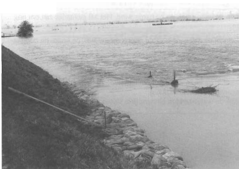
Gaten die dieper zijn dan 20 cm, waar geen zand uitkomt, moeten opgevuld worden met zandzakken.
