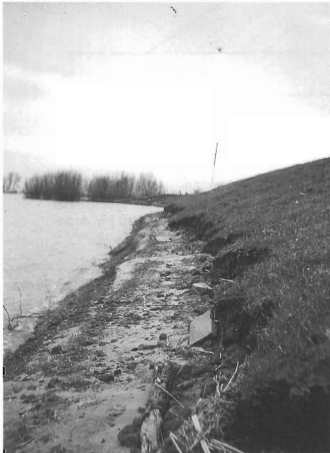
Tijdens hoogwater kan de grasmatt geschadigd worden door golven en stroming of door drijfvuil.
