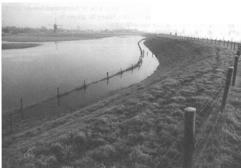
Door kwel kan het land achter de dijk blank komen te staan.
