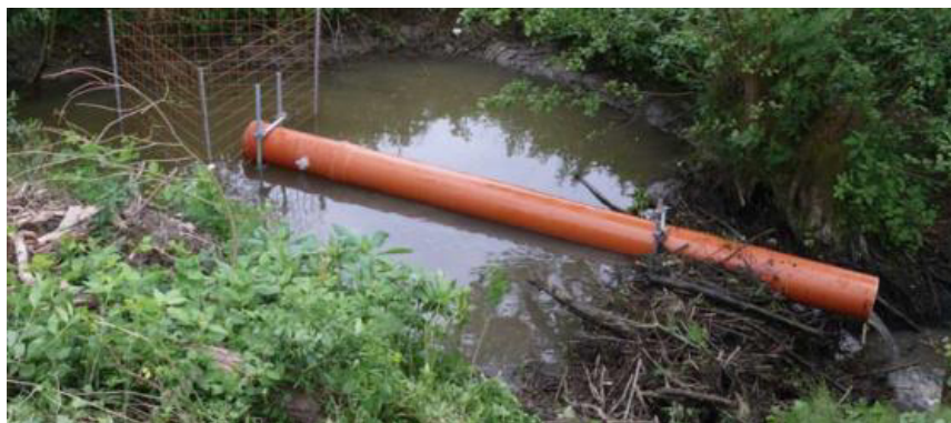
Abbildung 22 Drainagerohr mit Gitterkäfig im Oberlauf zum regulieren des Wasserstandes im Bibersee, modifiziert (Bayrisches Landesamt für Umwelt b, 2009)
