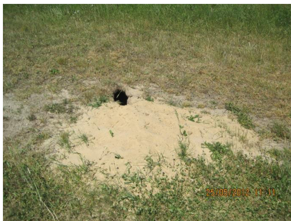
Abbildung 32 Hohlraum im Deich - Eingang zu einem Fuchsbau (Wappler 2012)
