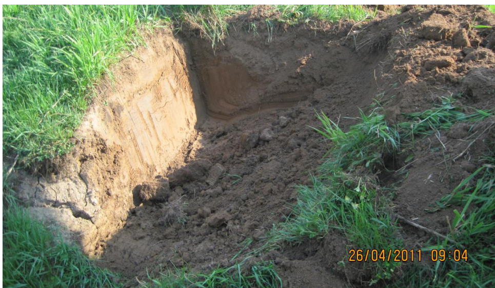
Abbildung 31 Grundsätzliche Schadensbehebung aufgegrabener Biberbau an einem Deich im Bereich des StALU WM (Wappler 2011)
