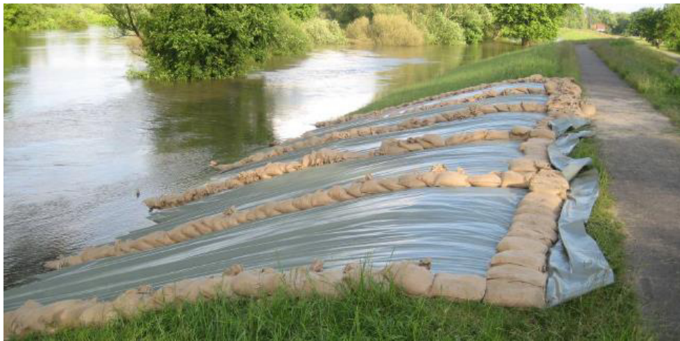
Abbildung 30 Temporäre Schadensbehebung "gesicherte Schadstelle,, modifiziert Ziltendorfer Niederung, Foto: Dr. Krüger, LUGV" (Clauß, 2013)
