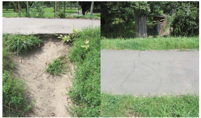
Abb. 75: Zu naher Bewuchs und Durchwurzeln können zu einer stärkeren Durchsickerung und zu Materialaustrag führen.
