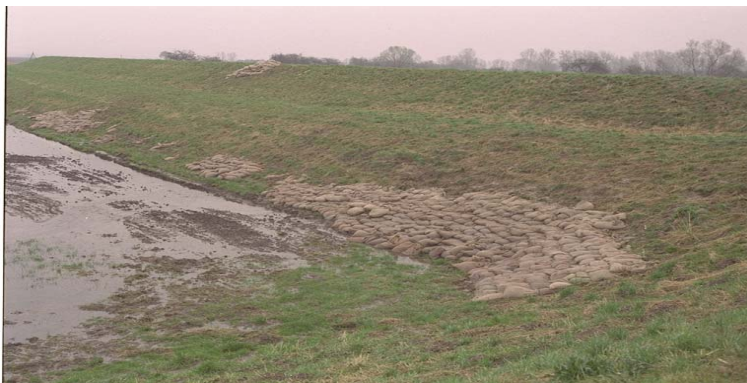
Abb. 50: Sandsackauflast zur Sicherung des landseitigen Böschungsfußes
