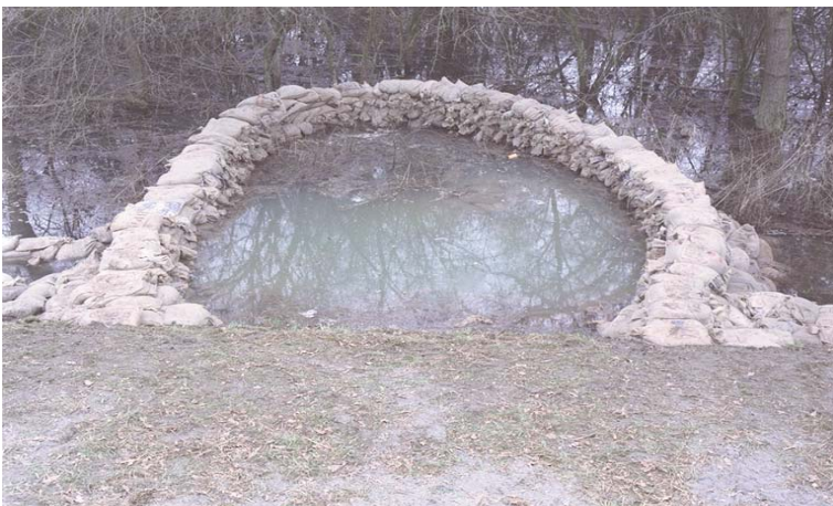
Abb. 45: Einzelner Fangedamm an einer lokalen Austrittsstelle
