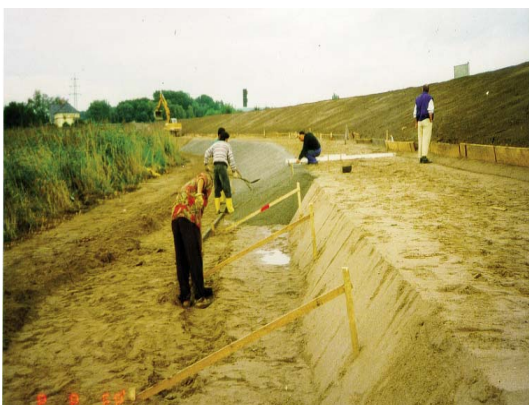
Abb. 20: Einbau des Fußfilters aus Porenbeton
