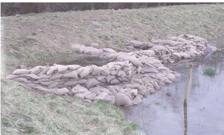
Abb. 46: Reihe mehrerer Quellkaden am landseitigen Deichfuß
