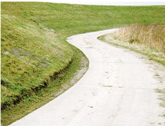
Abb. 18: Deichverteidigungsweg aus Stahlbeton
